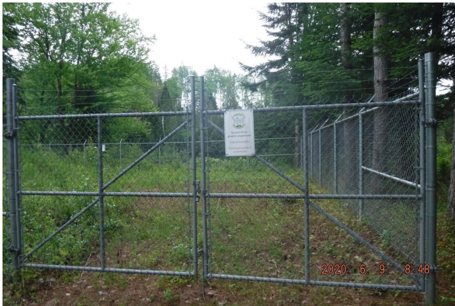
Photo 2 : Clôture d'accès au puits P1.
