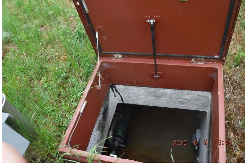
Photo 7 : Accès de service au puits P1.
