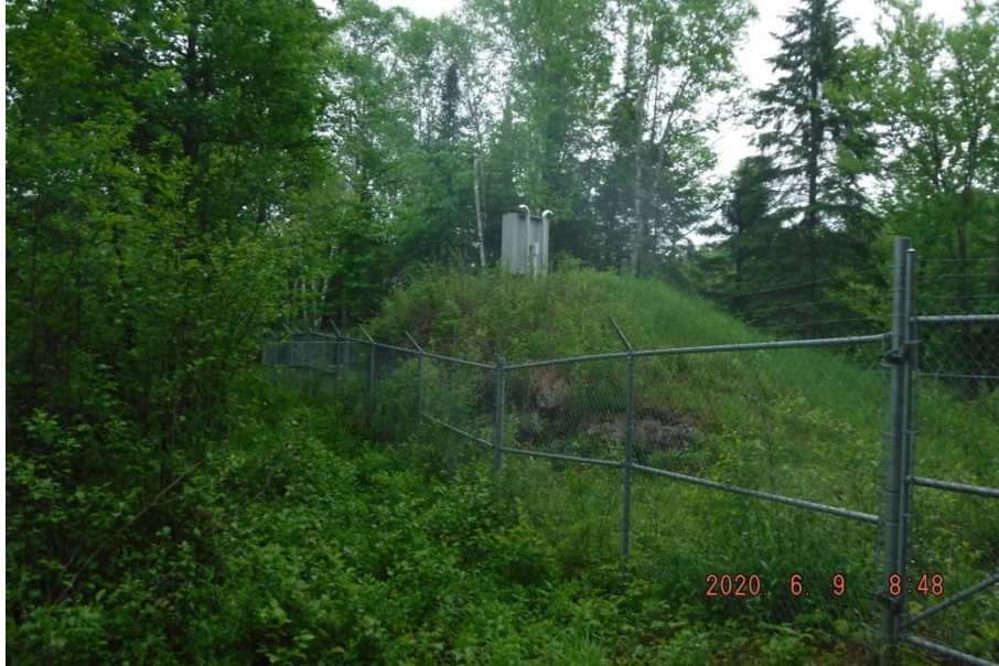
Photo 1 : Vue de l'emplacement du puits P1 (installation semi-enterrée).
